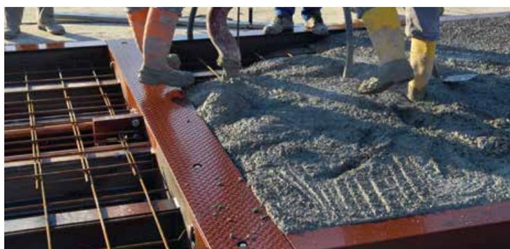
Pont-bascule réalisé en version fer-ciment.
